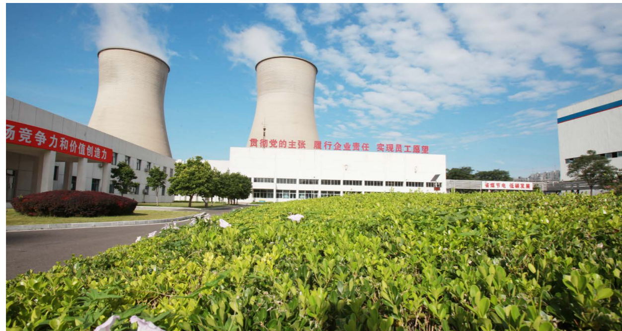
三河电厂——国内首创自主研发建设烟塔合一;国内首家300兆瓦级机组同步脱硫脱硝装置;河北省首家获环保绩效最高评级A级的火电企业
